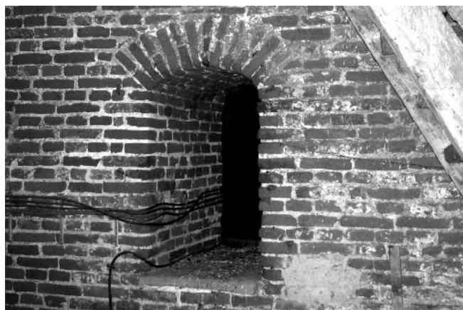
Metselwerk binnenzijde kerktoren
